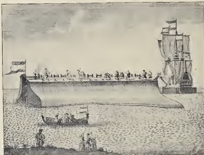
»KAMEEL OF SCHIPS-LICHTER OMDE OORLOGHS SCHEEPE OVER HET PAMPUS TE BRENGEN"»
